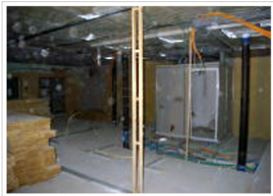
11、入隅：補強立込
