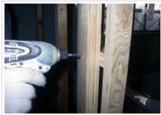
12、入隅：補強立込
