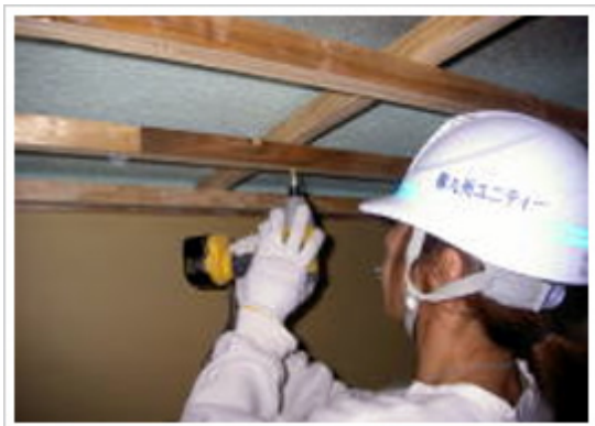
23、天井：野縁受取付
