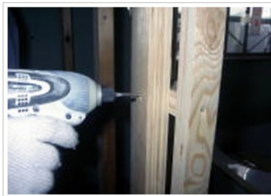
12、入隅：補強立込
