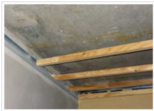
22、天井：野縁取付
